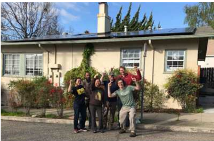
민중의 힘 태양광 협동조합이 캘리포니아주 오클랜드 지역 사회활동가 사무소에 최초로 설치한 태양광발전설비
